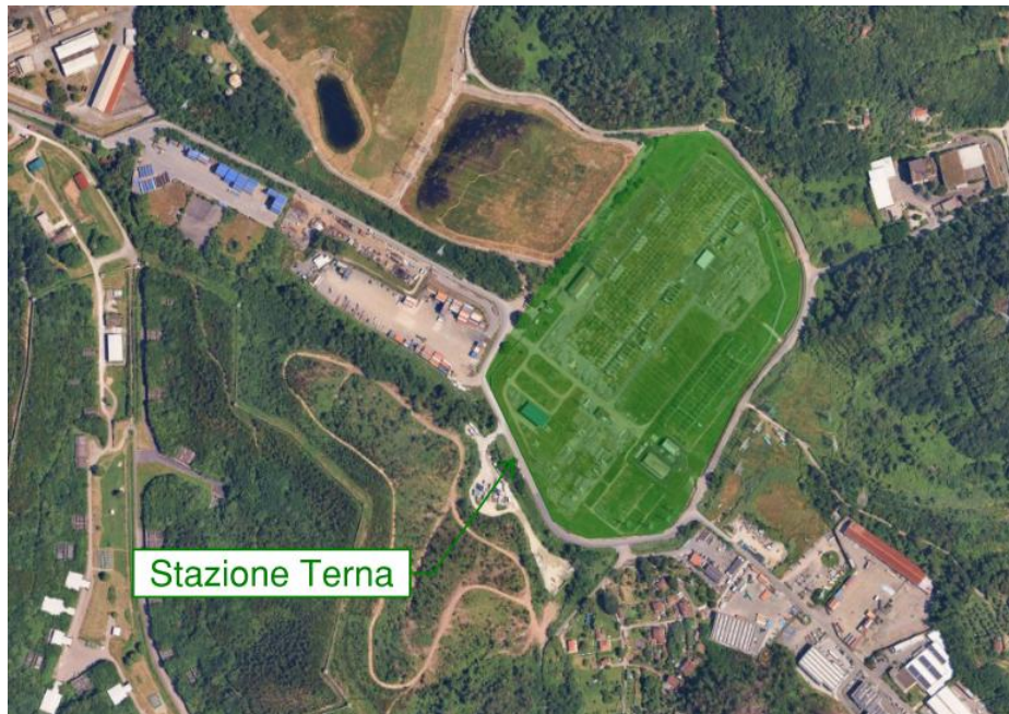
Figura 4.5-1 Panoramica della S.E. denominata “La Spezia”
