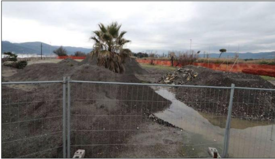
Figura 7.1-5 Area di Cantiere URBA 3
